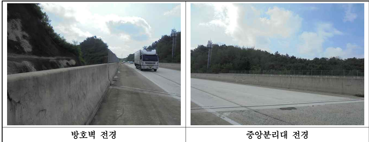
【사진 27.3.21】 방호벽 및 중앙분리대 전경
