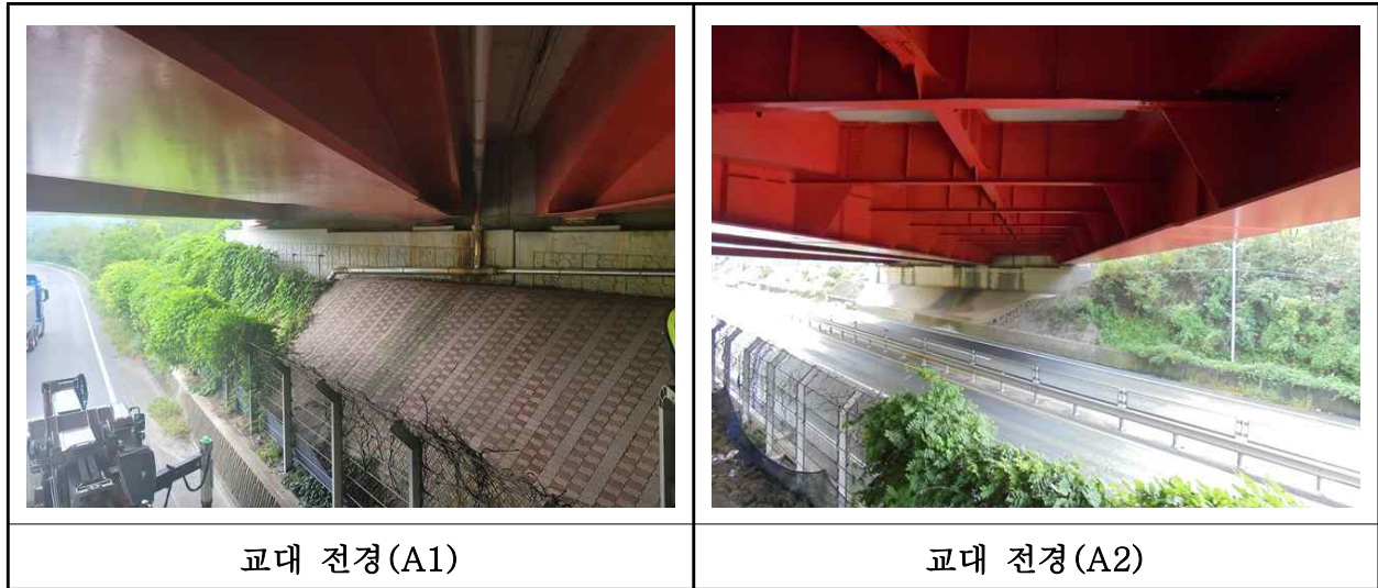
【사진 27.3.31】 교대 전경
