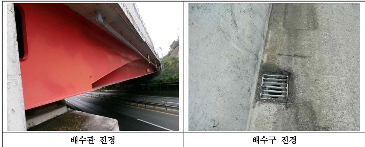
【사진 27.3.19】 배수시설 전경
