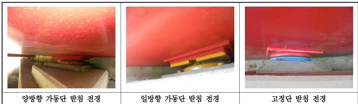
【사진 27.3.33】 교량받침 전경
