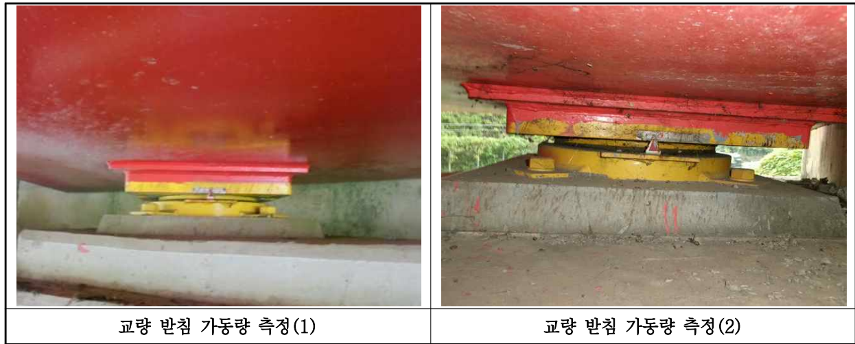
【사진 27.3.13】 교량받침 이동량 측정
