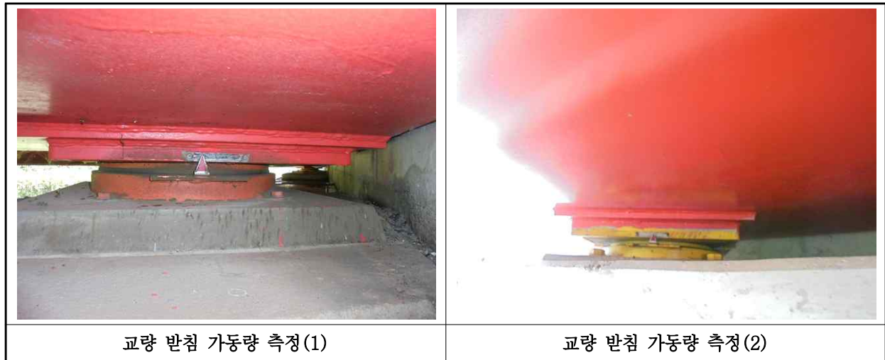
【사진 27.3.36】 교량받침 이동량 측정
