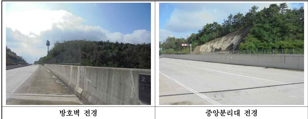
【사진 27.3.44】 방호벽 및 중앙분리대 전경
