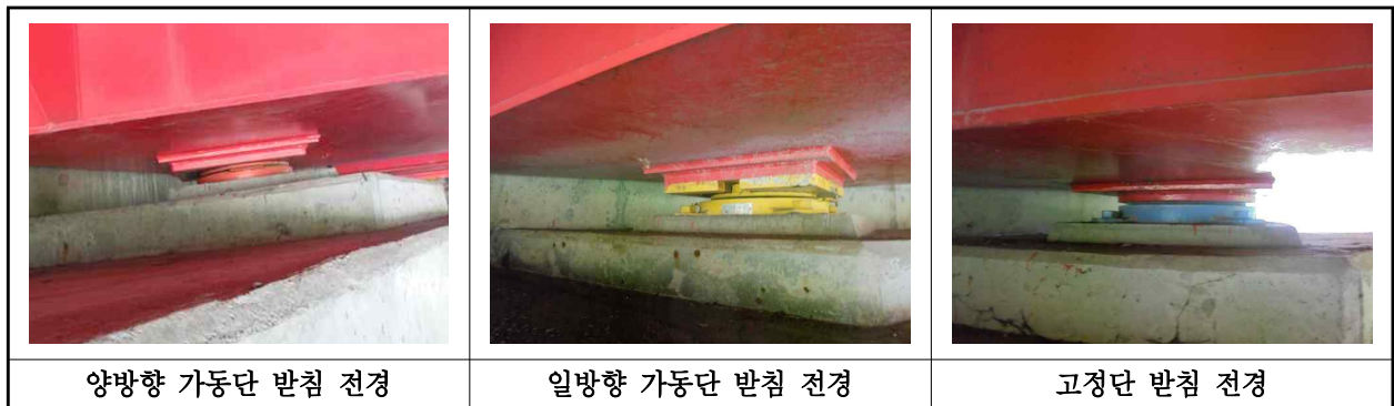
【사진 27.3.10】 교량받침 전경
