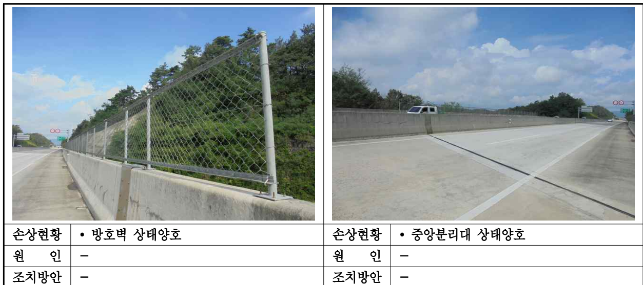
【사진 27.3.22】 방호벽 및 중앙분리대 외관조사 결과
