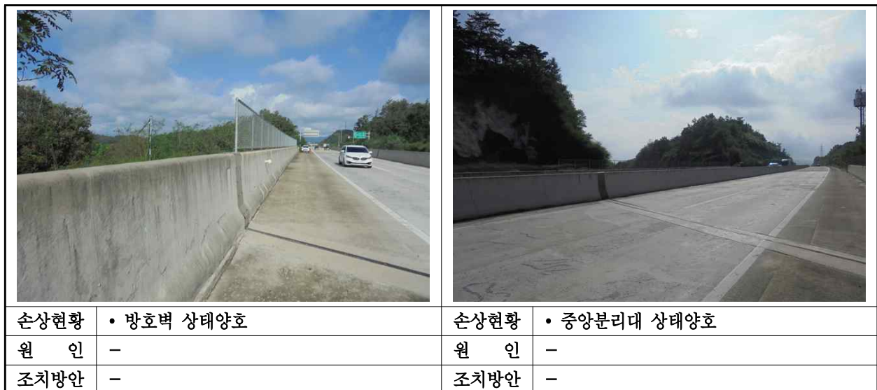
【사진 27.3.45】 방호벽 및 중앙분리대 외관조사 결과
