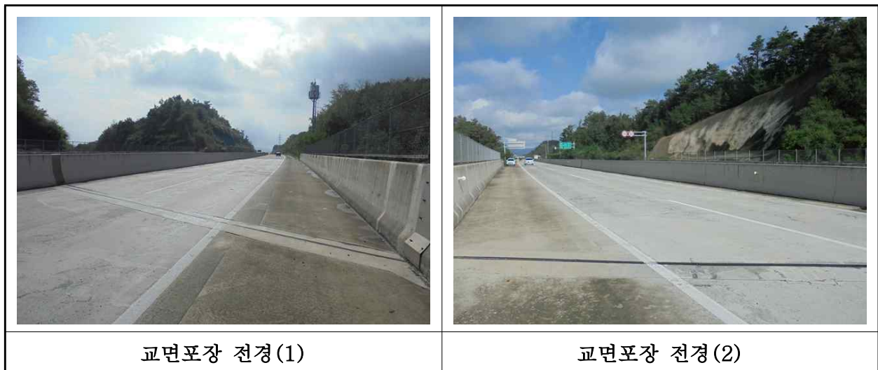
【사진 27.3.40】 교면포장 전경
