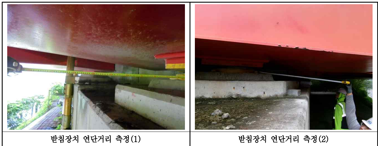
【사진 27.3.12】 교량받침장치 연단거리측정
