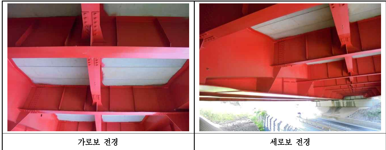
【사진 27.3.29】 가로보 및 세로보 전경
