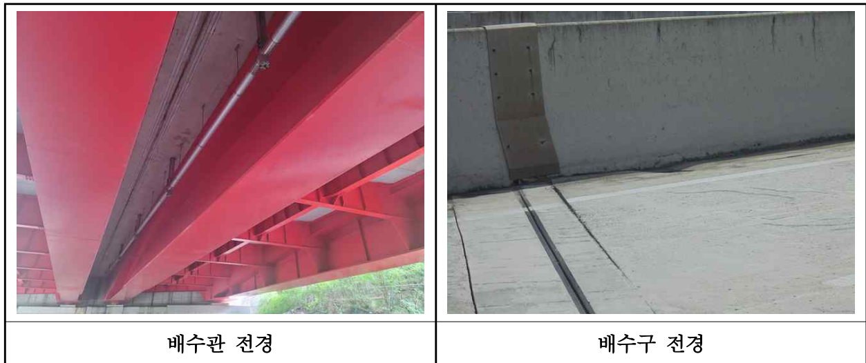
【사진 27.3.42】 배수시설 전경
