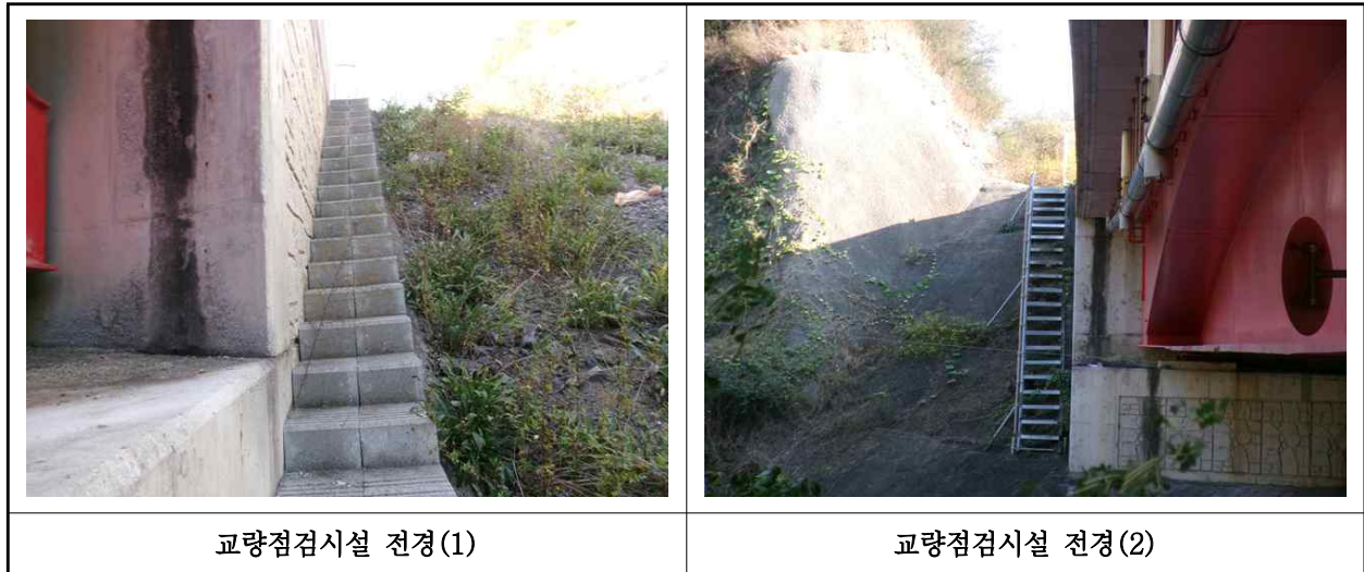
【사진 27.3.23】 교량 점검시설 전경
