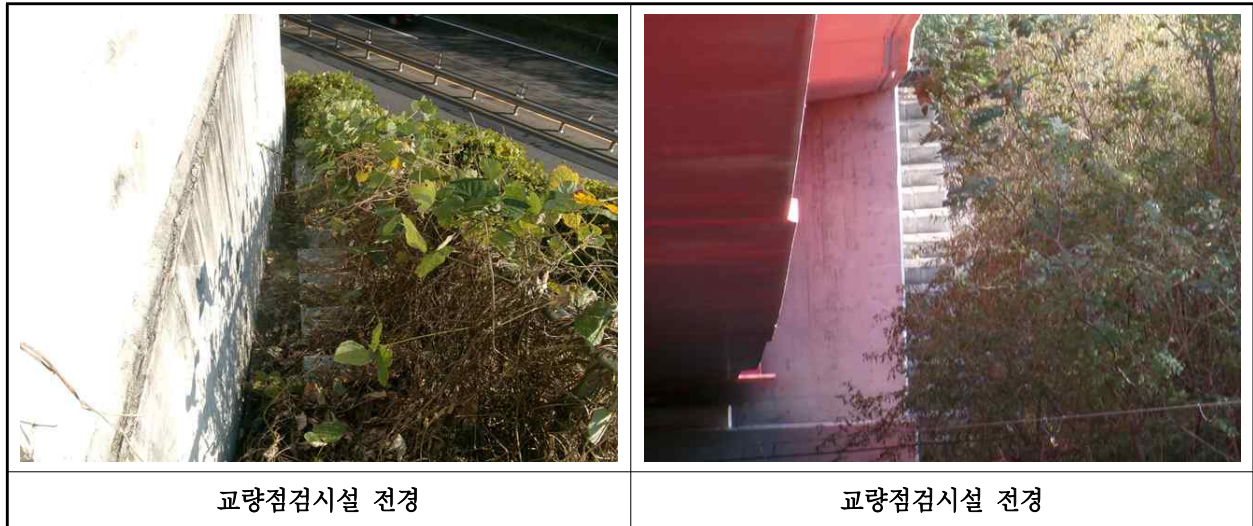
【사진 27.3.47】 교량 점검시설 전경
