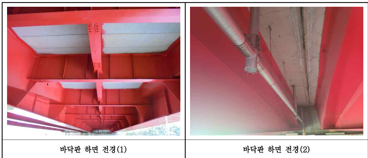
【사진 27.3.25】 바닥판하면 전경
