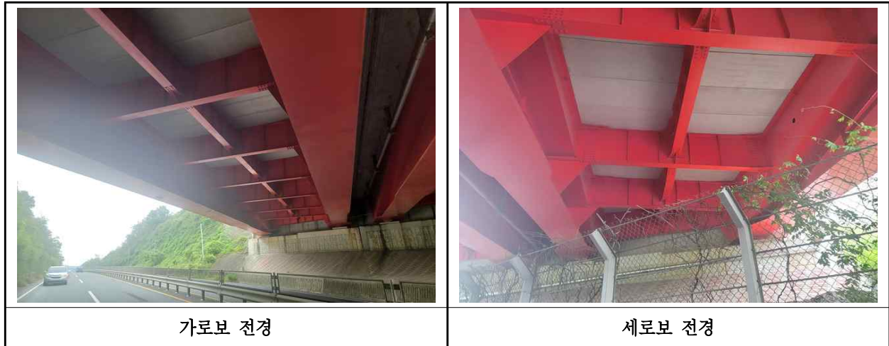
【사진 27.3.6】 가로보 및 세로보 전경
