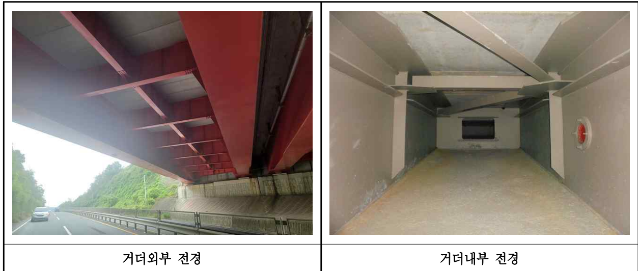
【사진 27.3.4】 거더 전경
