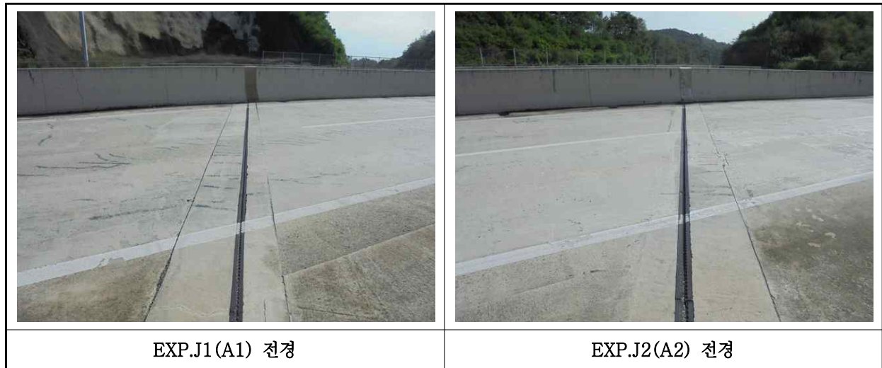
【사진 27.3.37】 신축이음장치 전경
