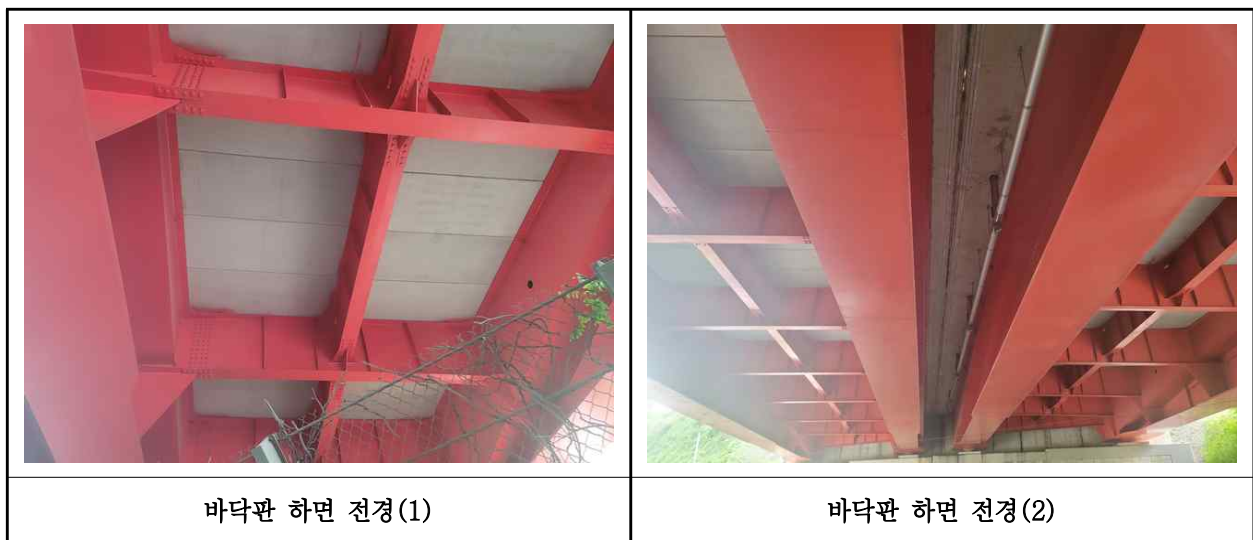
【사진 27.3.2】 바닥판하면 전경
